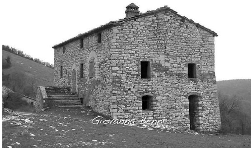
Fig. 8-9: Casa colonica a fianco della torre di galera detta "Ranco".
