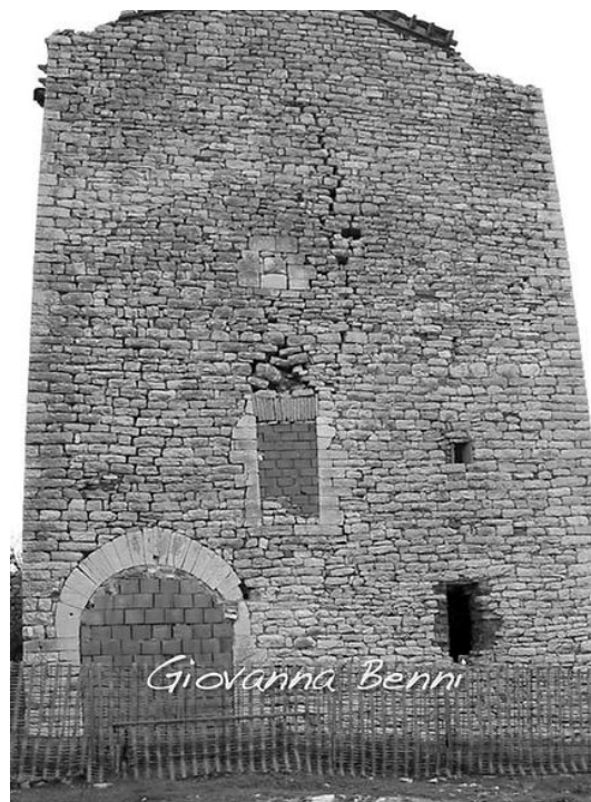
Fig. 6: lato sinistro della casa-torre.
