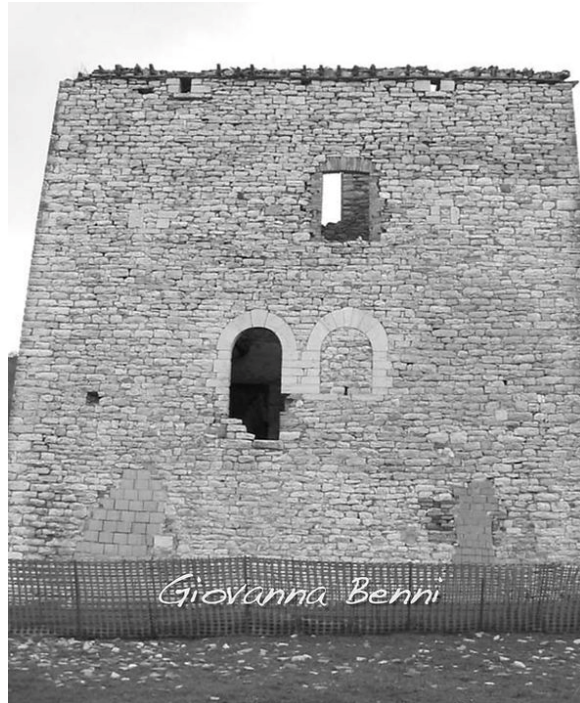
Fig. 3: Galera: prospetto anteriore della facciata della casa-torre.
